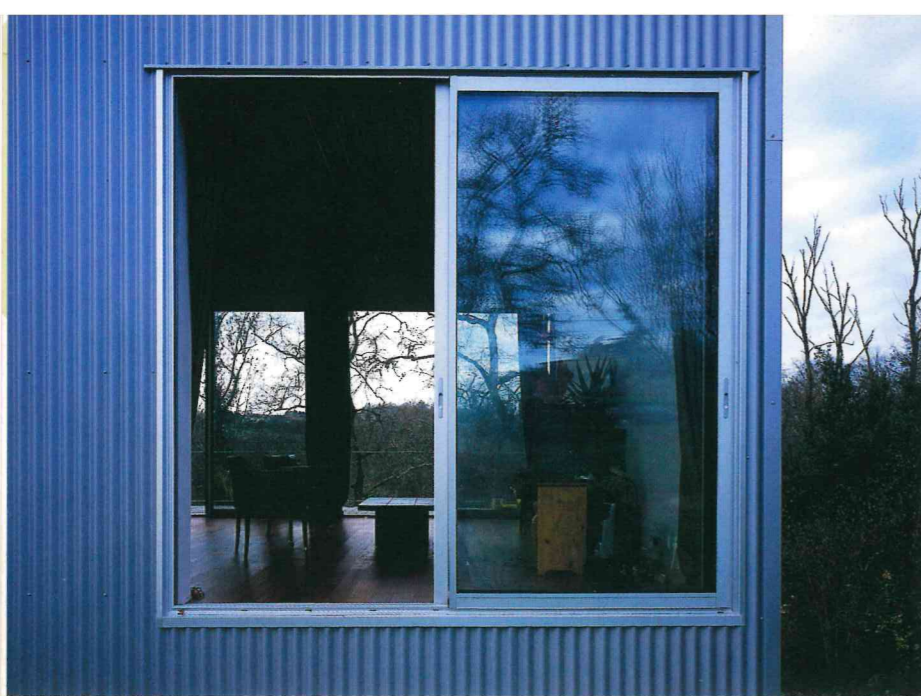
Vue traversante sur le séjour depuis la façade nord-est. La maison étant peu profonde (5,50 m), l'essentiel des pièces bénéficie d'une double orientation favorisant ventilation naturelle et ensoleillement.
