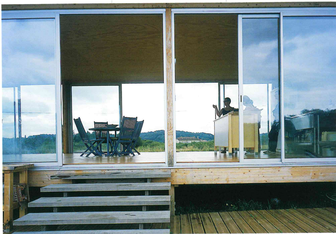
Façade ouest. Les deux flancs vitrés organisent des transparences superposant les divers éléments du paysage.
