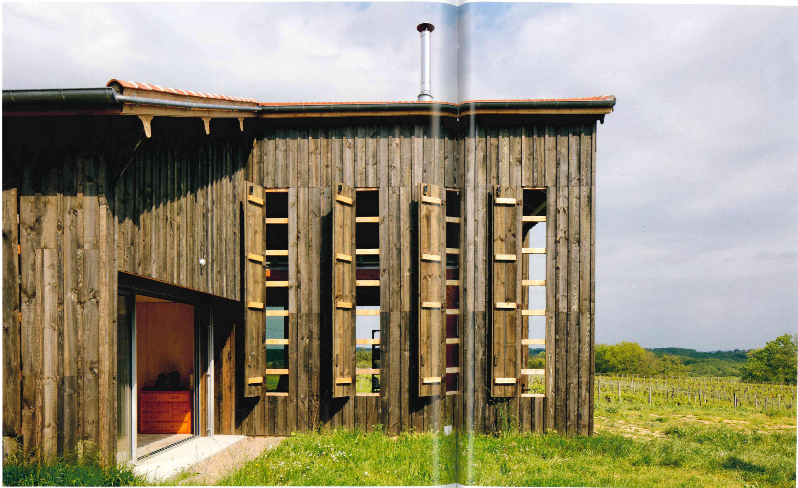
Façade ouest. Ouverts, les volets de ventilation créent une vue traversante sur l'habitation et le paysage lorsque les coulissants de la façade opposée sont eux aussi ouverts.
